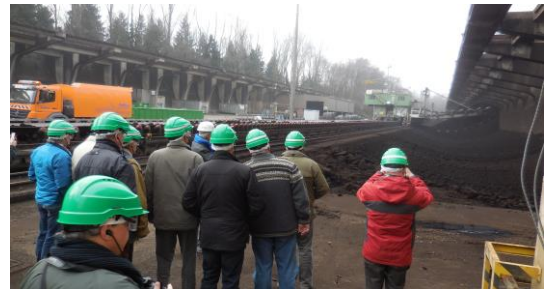
Kohlebunker im Kraftwerk
