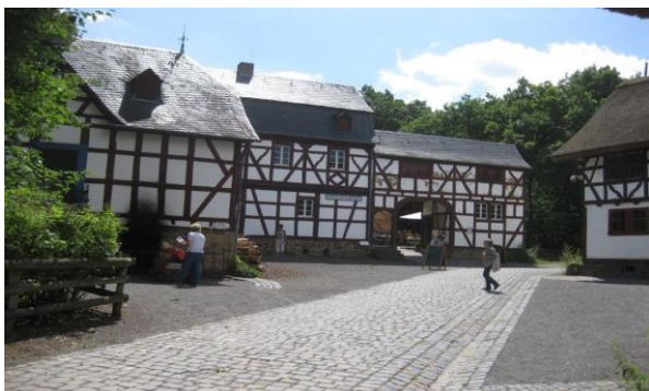
Wunderschöner Fachwerkbau (Gasthof zur Post) mit Torbogen Links die kleine Schule mit Backhaus im Kellergeschoss
